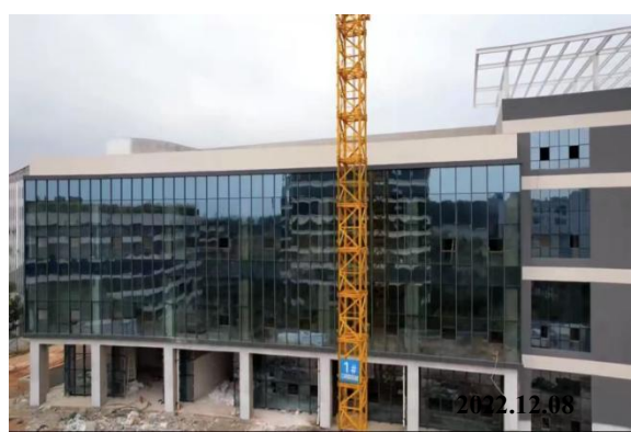
厂区在建工程-中试生产基地大楼
