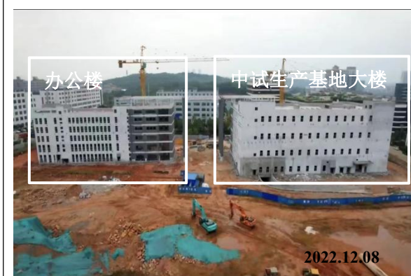
厂区在建工程
