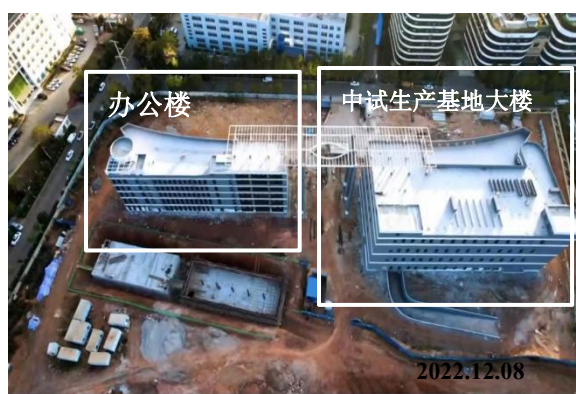
厂区在建工程
