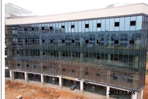
厂区在建工程-办公楼
